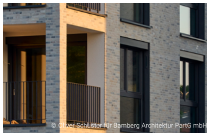
Fassade im Detail: VEKA SOFTLINE 82 MD Profile in dunkler Rahmung fügen sich ins Ziegelbild.
