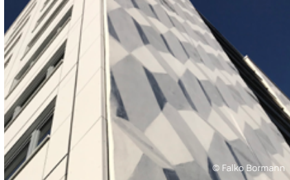
Modernisierte Vorhangfassade mit dahinterliegender Fensterebene; „Waffeleisenstruktur“ auf der Giebelfassadenseite
